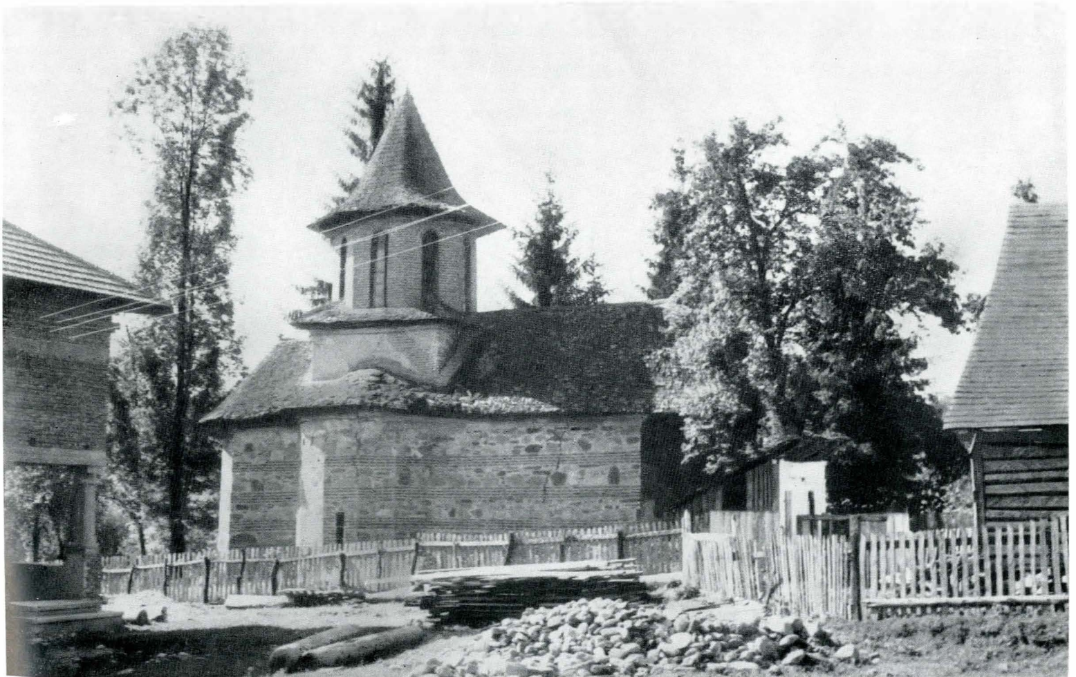
Fig.2. Fațada de nord, înainte de restaurare
