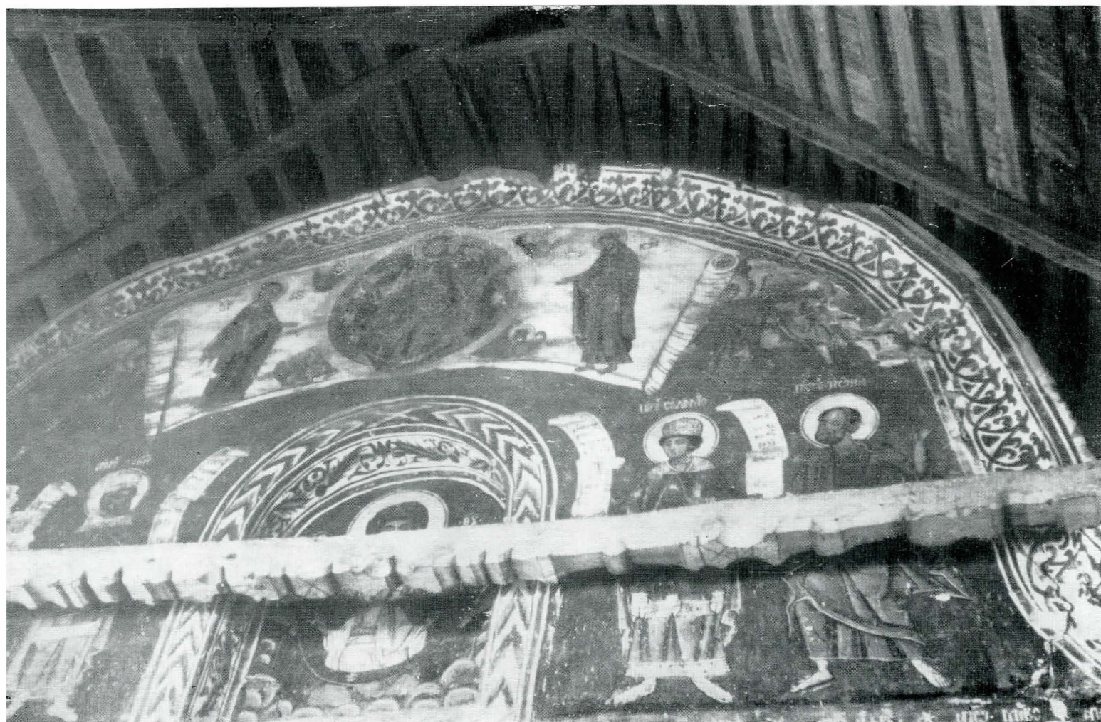
g. 4. Grindă tirant înainte de restaurare.
